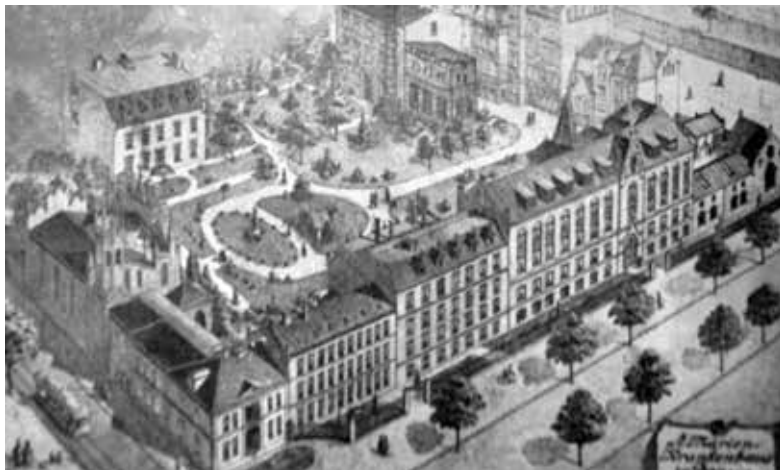
Widok ogólny rozbudowywanego z biegiem lat kompleksu szpitalnego boromeuszek. Wewnątrz kwartału powstało założenie ogrodowe dla pacjentów, F. Steffen, Geschichte des St. Marien-Krankenhauses und des mit ihm verbundenen katholischen Mädchenwaisenhauses , Danzig 1927
